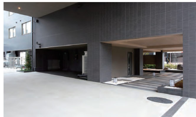
【屋内階段出入口】
